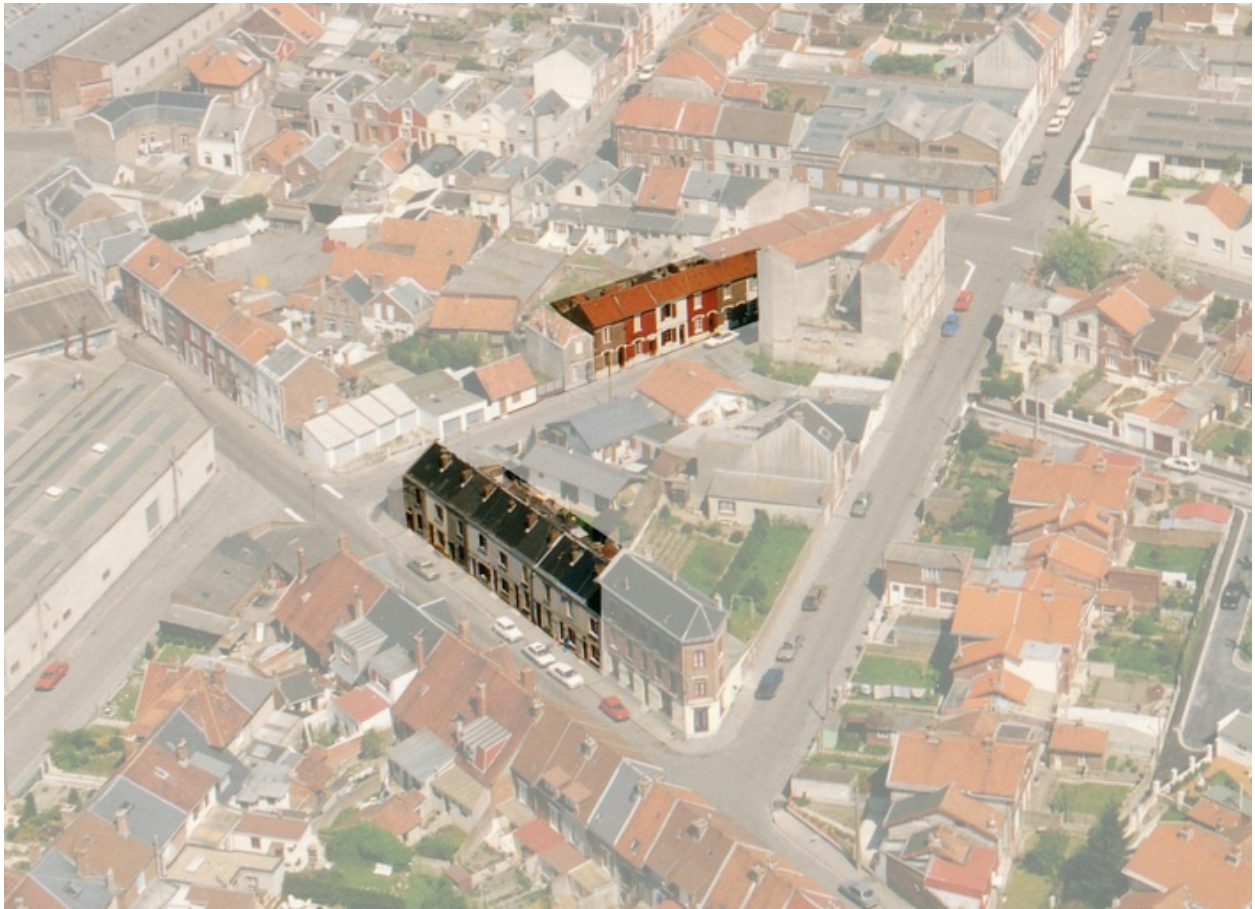
Vue aérienne vers 1989 (BM Saint-Quentin).
