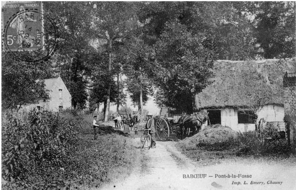
Ferme repérée, Pont à la Fosse. Avant 1914 (AP).
