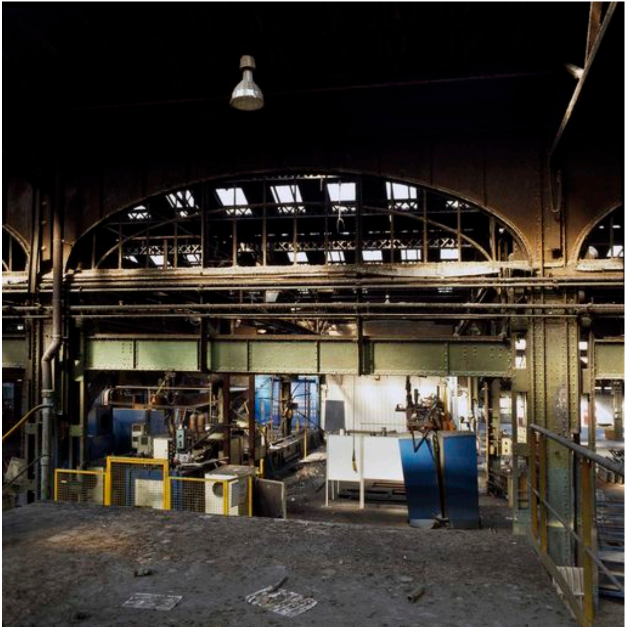
Détail de la structure.
