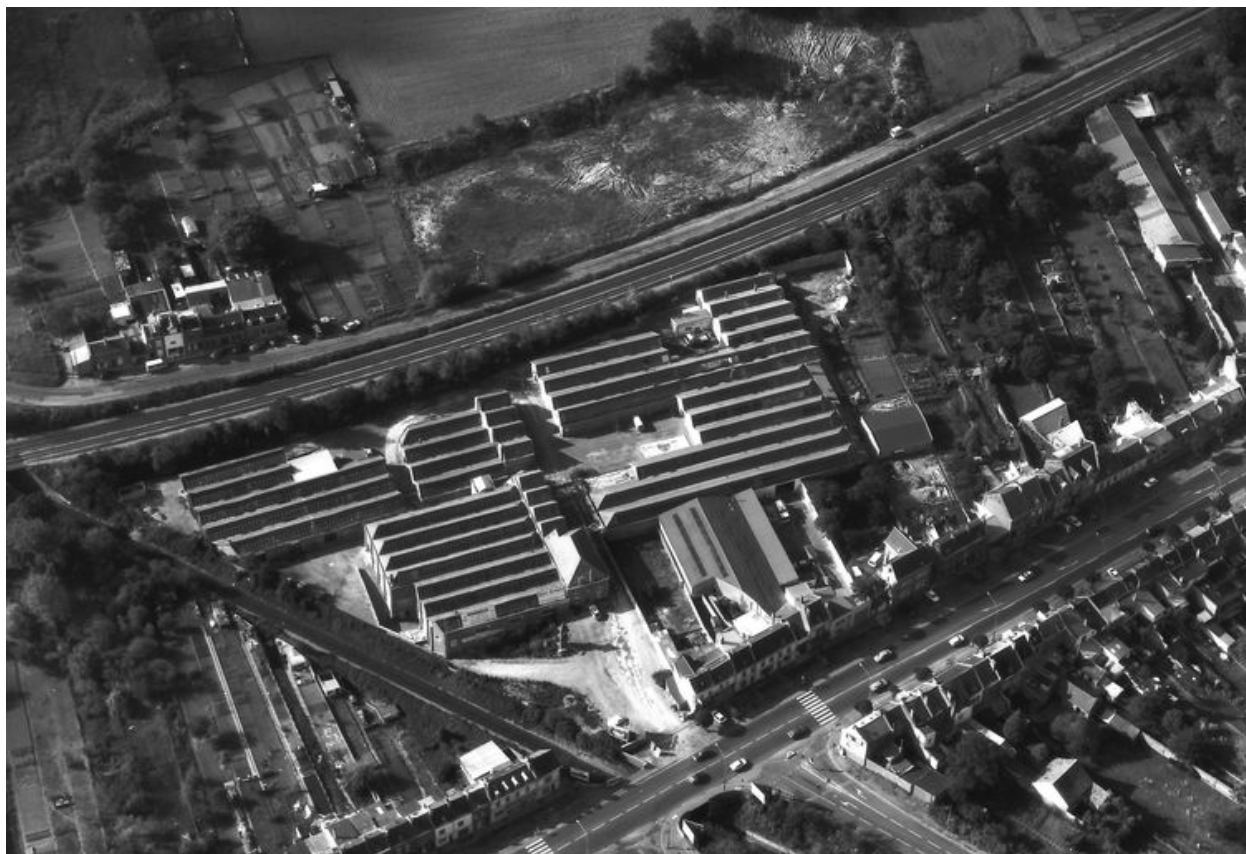
Vue aérienne, flanc ouest.
