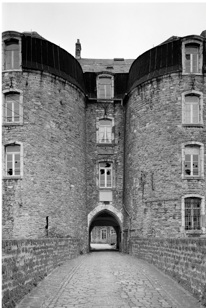
Façade sur pont en cours de restauration.
