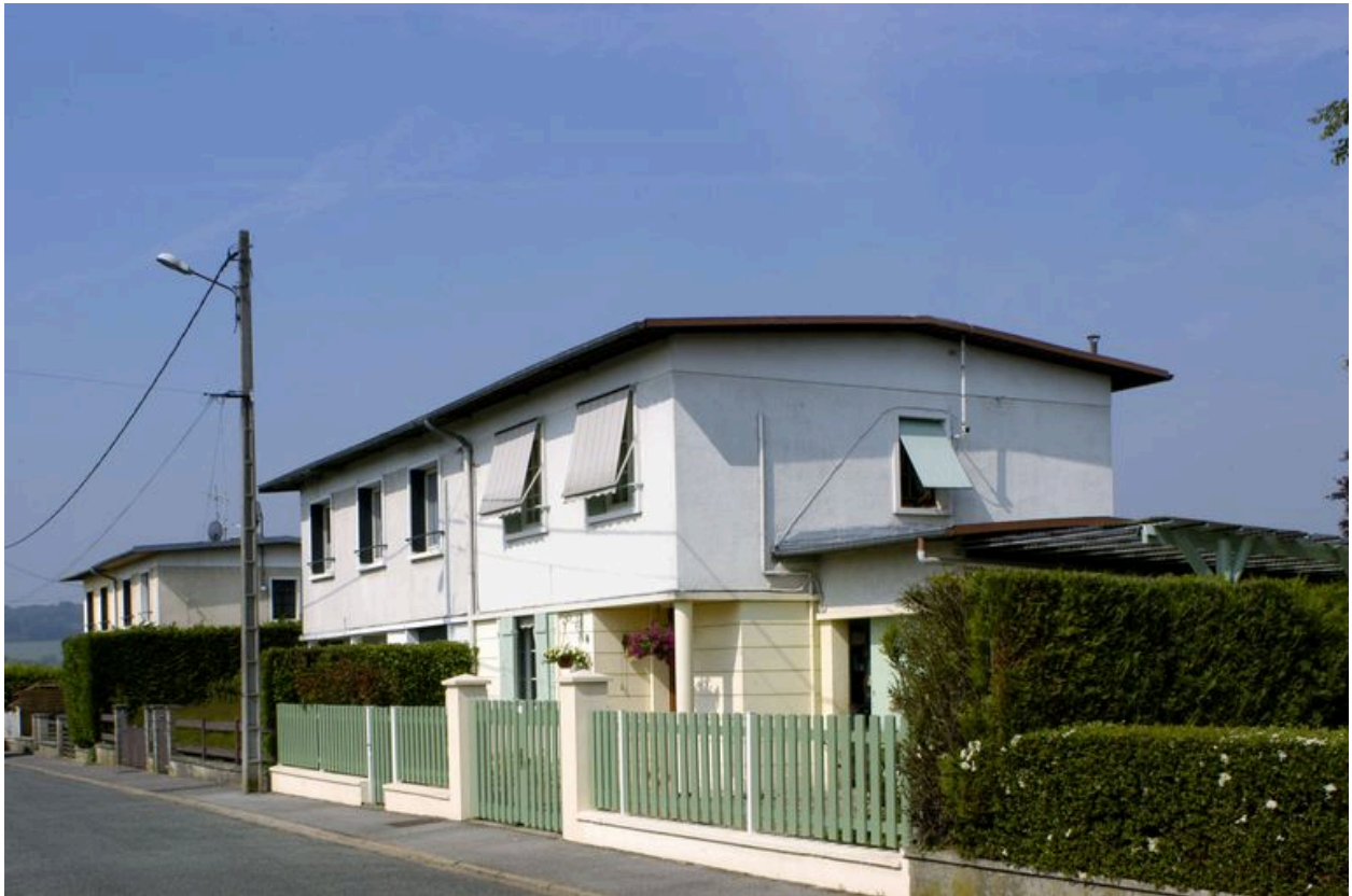
Vue générale des deux dernières maisons jumelles, façade sur rue.
