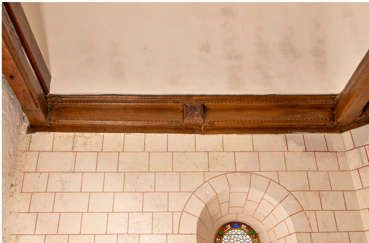
Poutre sablière et blochet sculpté dans la première travée du chœur (côté nord).
