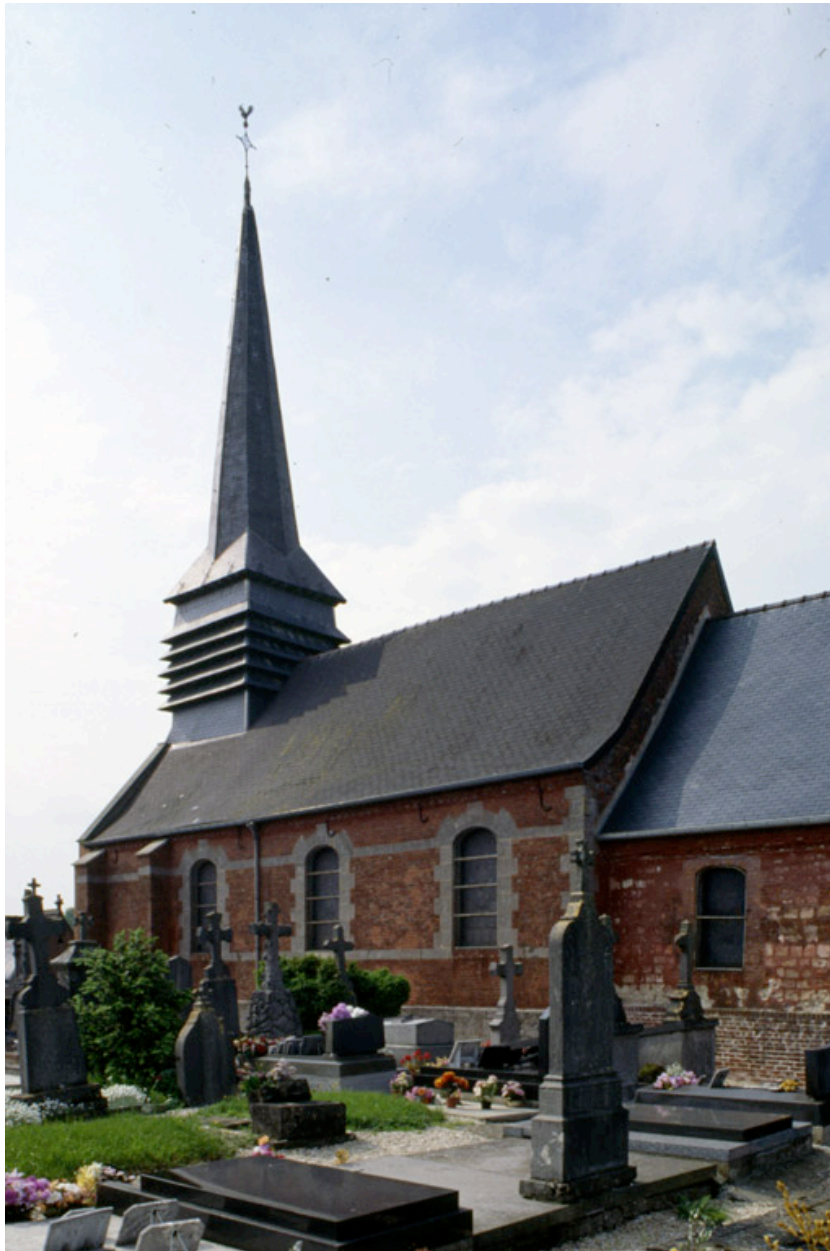
Vue partielle depuis le sud-est.
