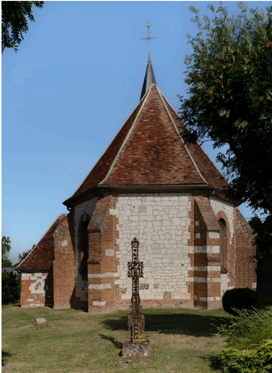
Vue du chevet depuis le sud-est.
