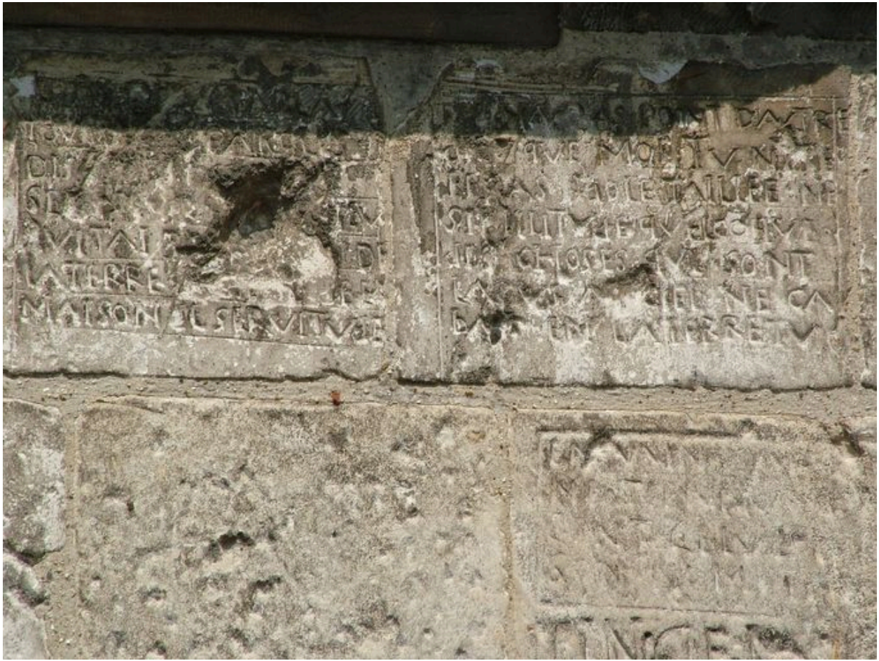
Graffitis sur le mur extérieur du clocher, 17 ou 18e siècle.
