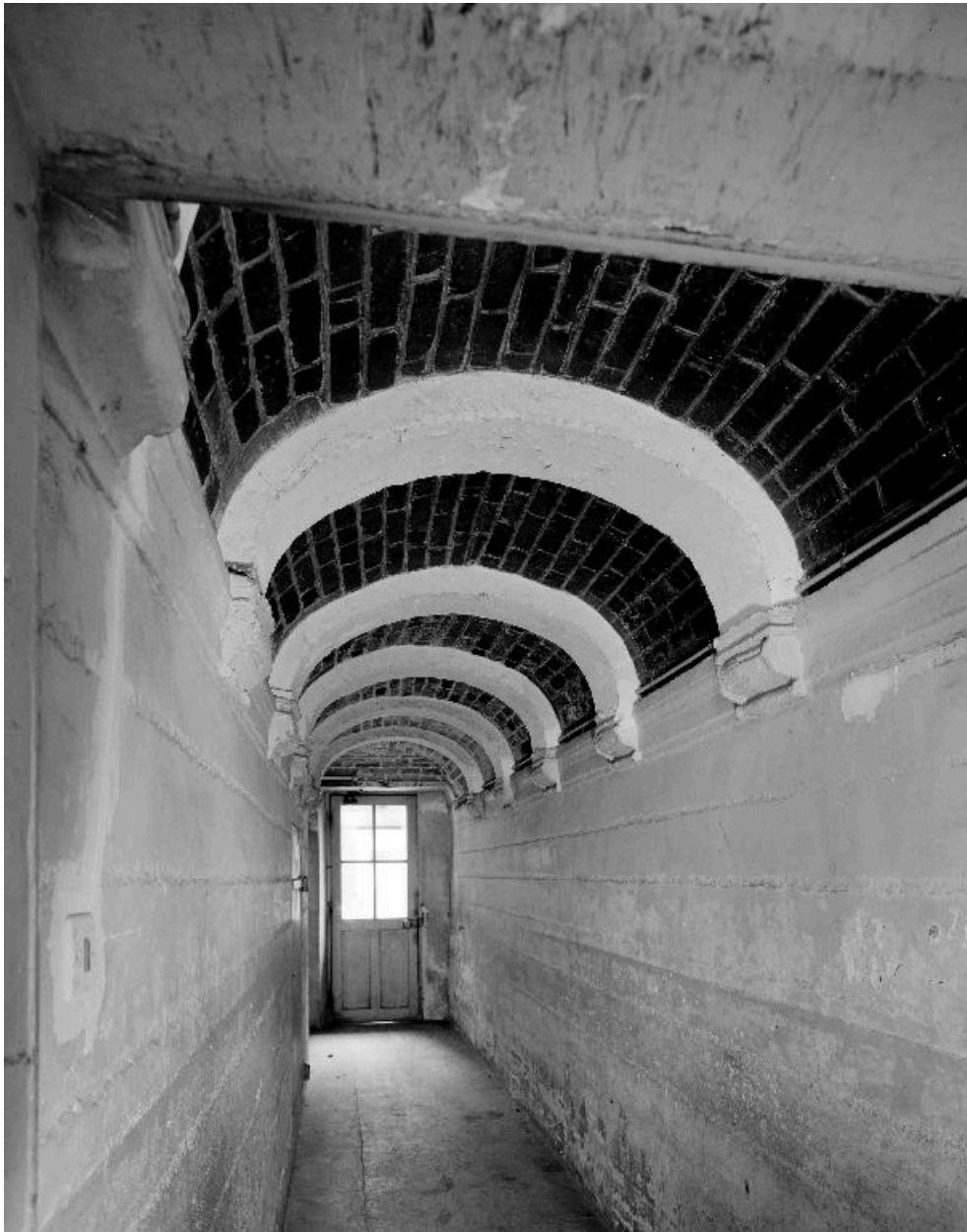
Escalier sud-est des offices : vue du couloir parallèle à la première volée.
