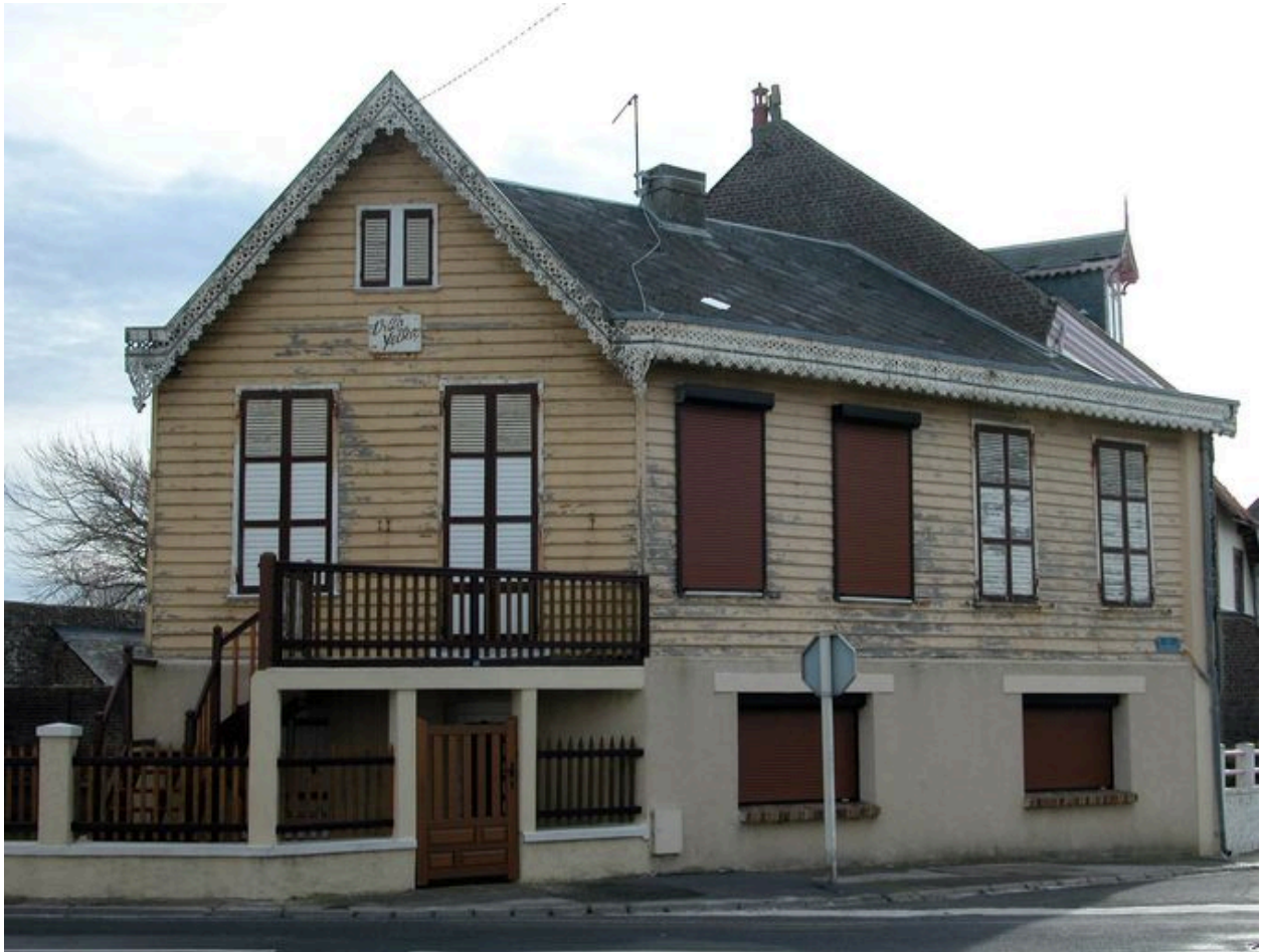
Maison dite Yelka, avec essentage de planches, 48 rue du Général-Leclerc (1988 BE 28).
