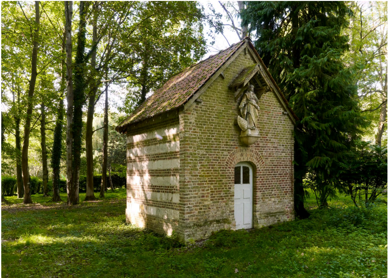
Vue d'ensemble de la chapelle, depuis l'est.
