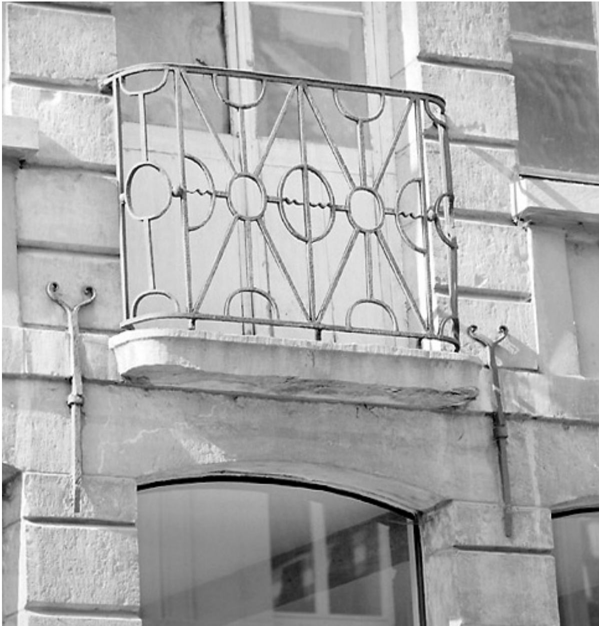
Façade, étage, travée centrale, détail : balcon.
