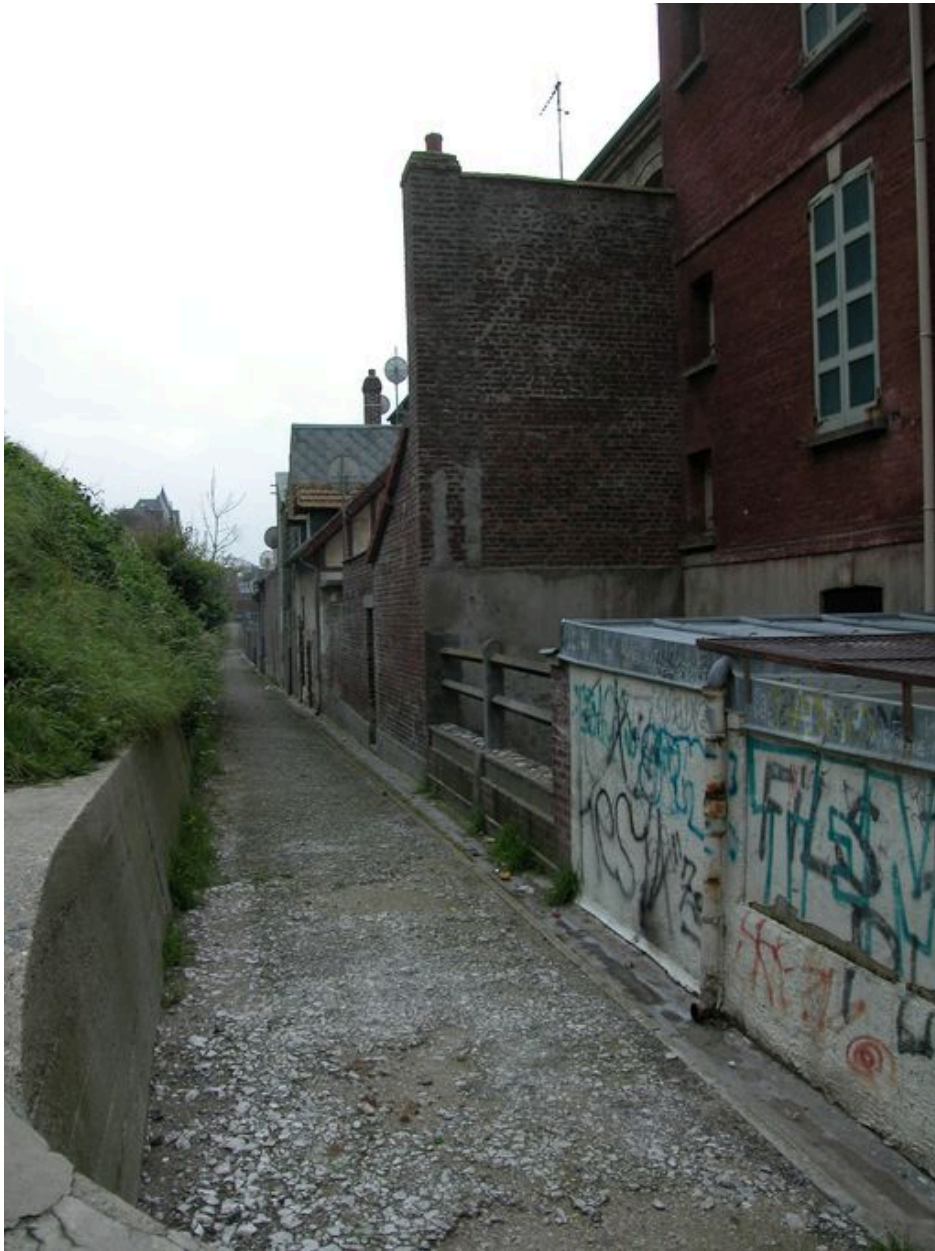
Ruelle des Matelots, façades arrières des maisons de la rue Jules-Barni, vue depuis le nord.
