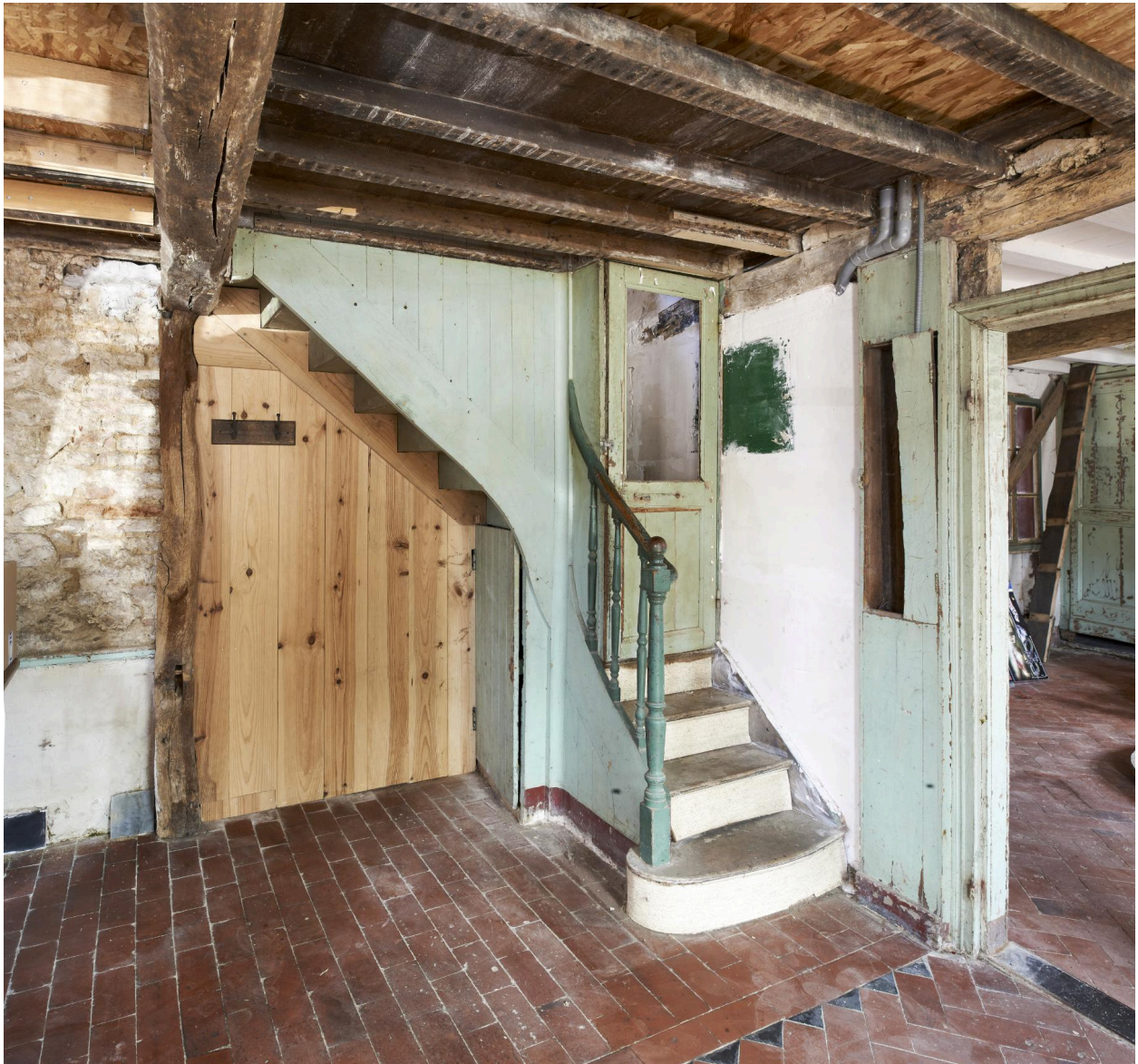
Intérieur, escalier d'accès à l'étage.
