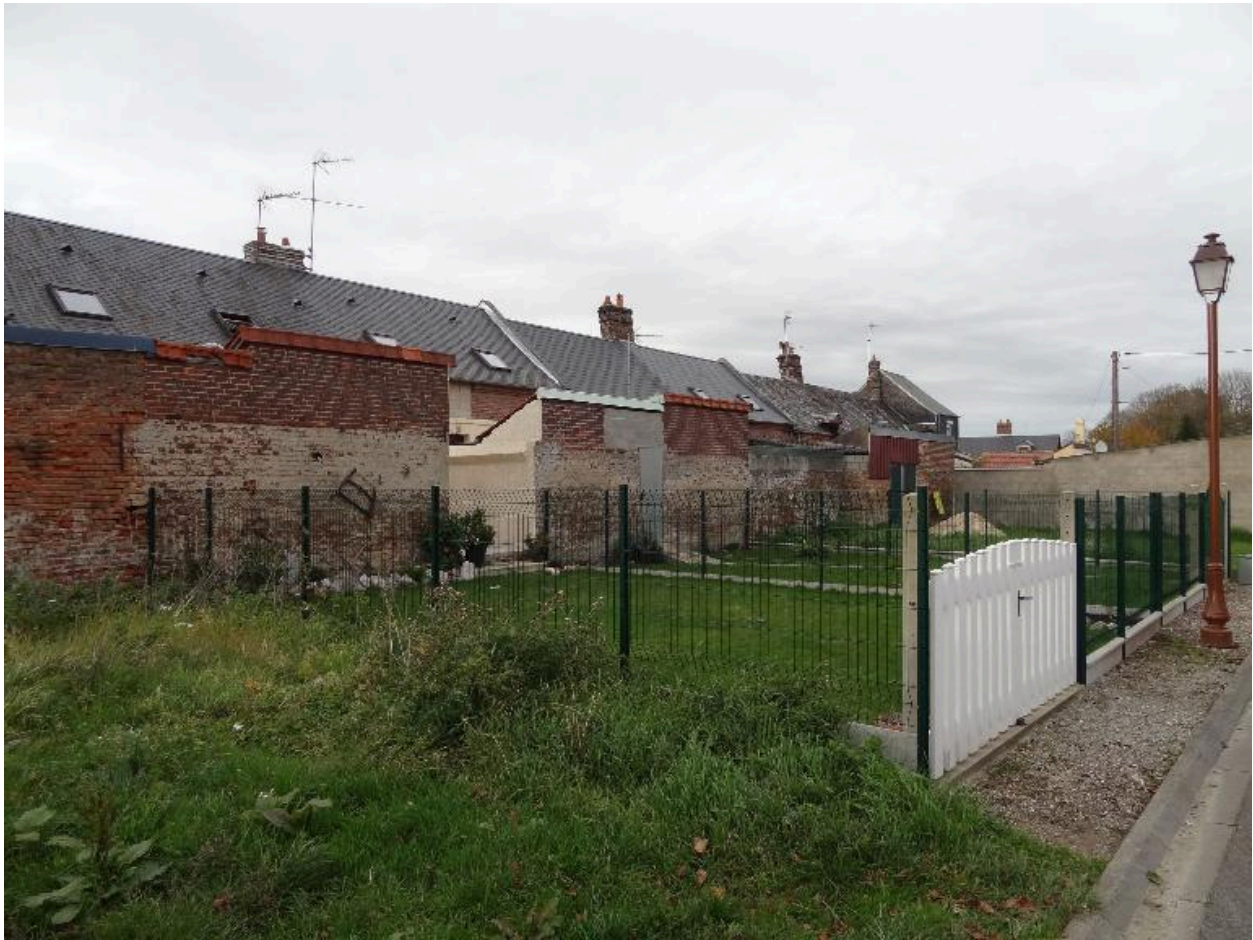
Vue des façades arrières des ateliers et des logements.
