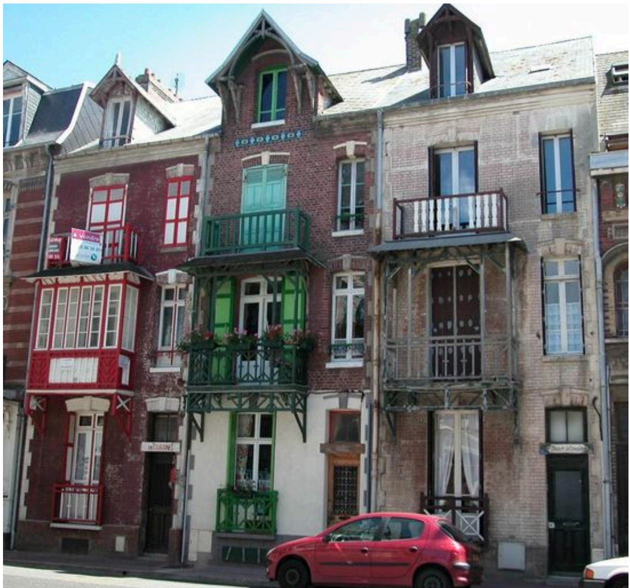
Élévation à 3x2 travées (10, 12, 14 avenue du Maréchal-Foch).
