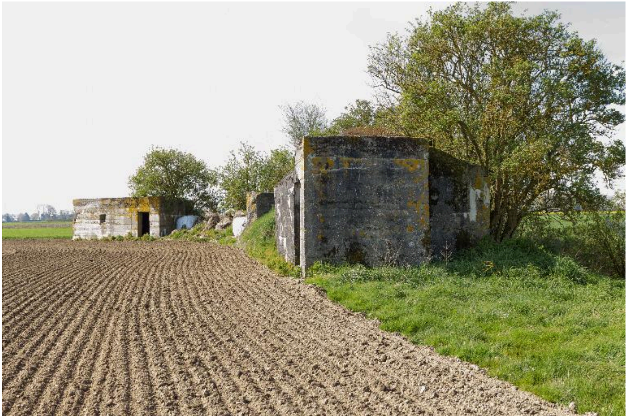
Vue d'ensemble vers le sud-ouest. Au premier plan le bâtiment 4 avec son entrée pare-souffle (?)
