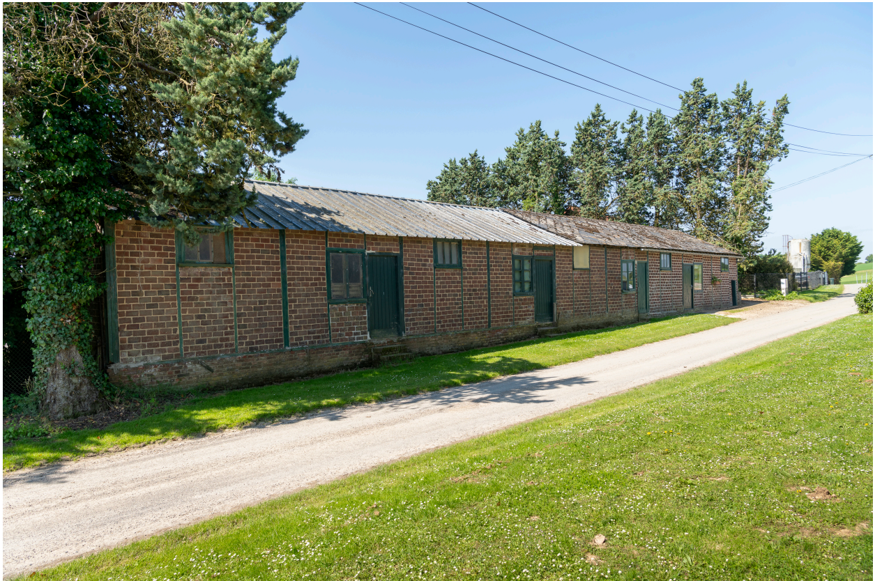
Anciens logements pour les ouvriers saisonniers, vue prise depuis le nord-est.
