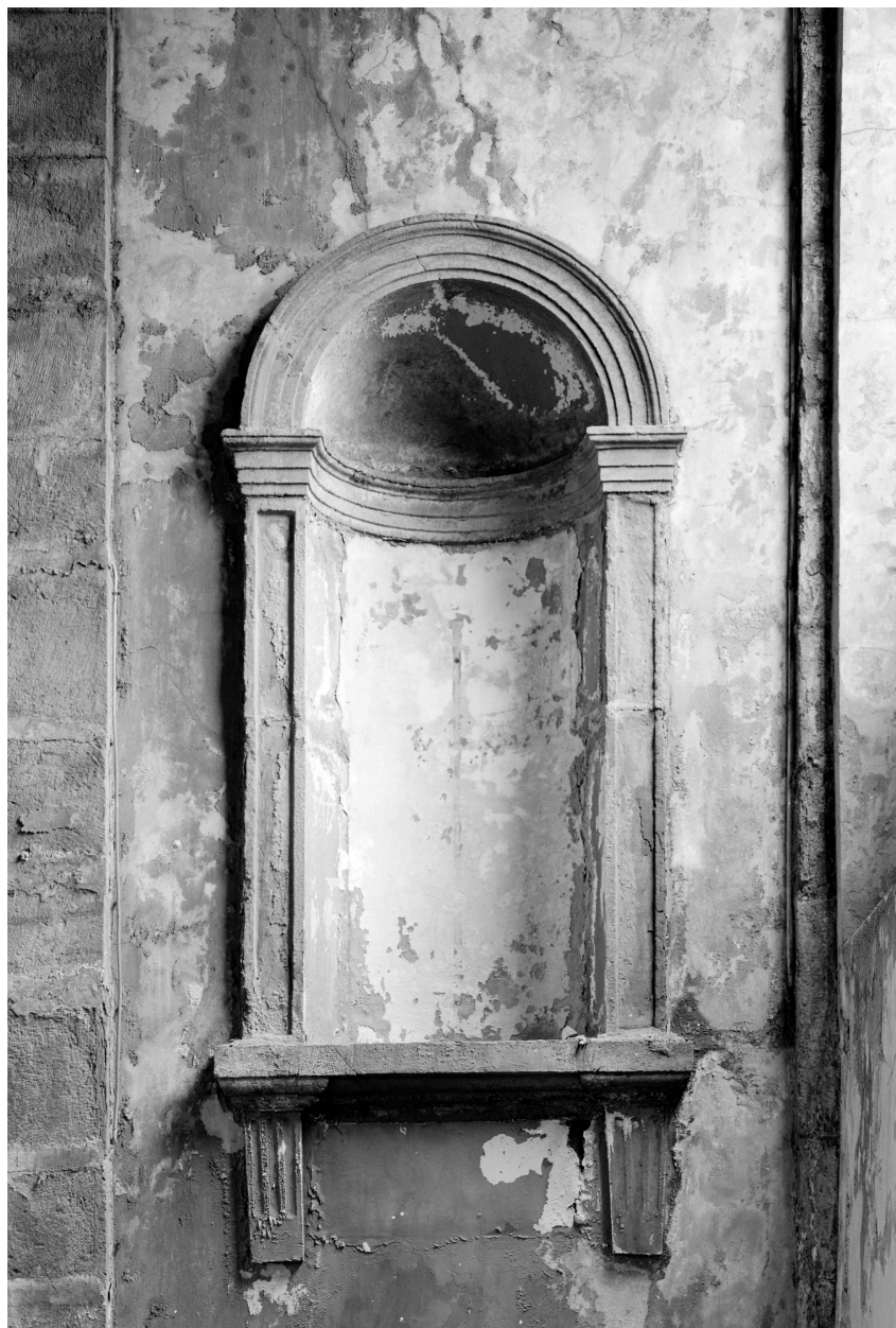
Chapelle, transept ouest, niche.
