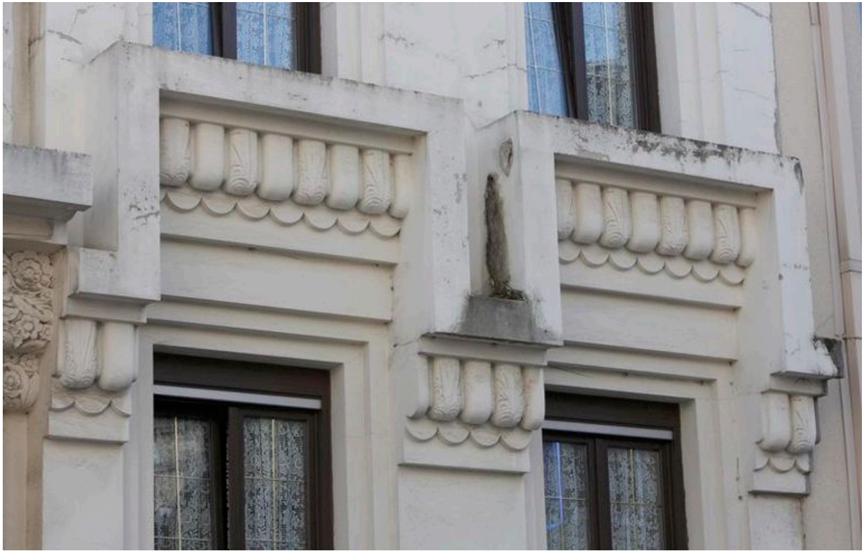
Balcons aux motifs tubulaires.
