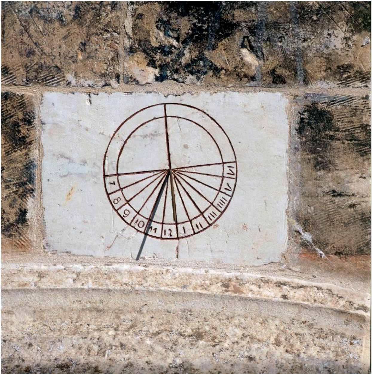
Cadran solaire gravé sur le mur sud de la nef, au-dessus de la porte.
