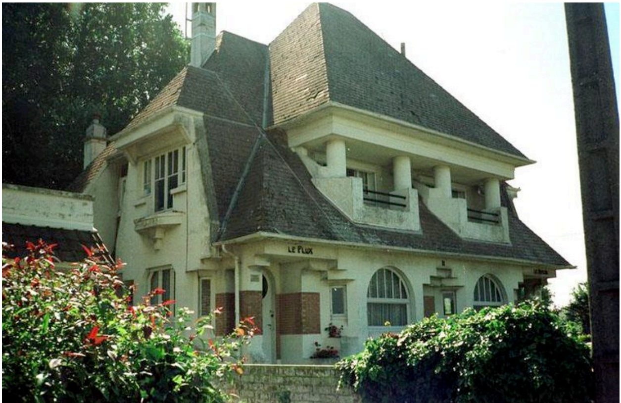
Le Flux. Vue générale depuis le nord.
