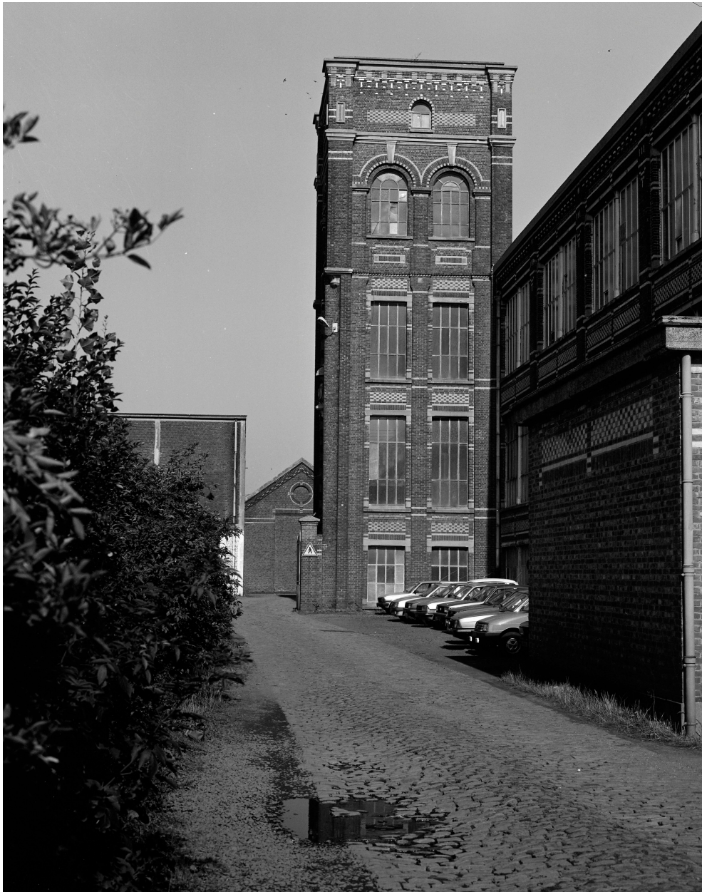
Atelier de fabrication et tour abritant l'escalier. Vue prise vers le nord.
