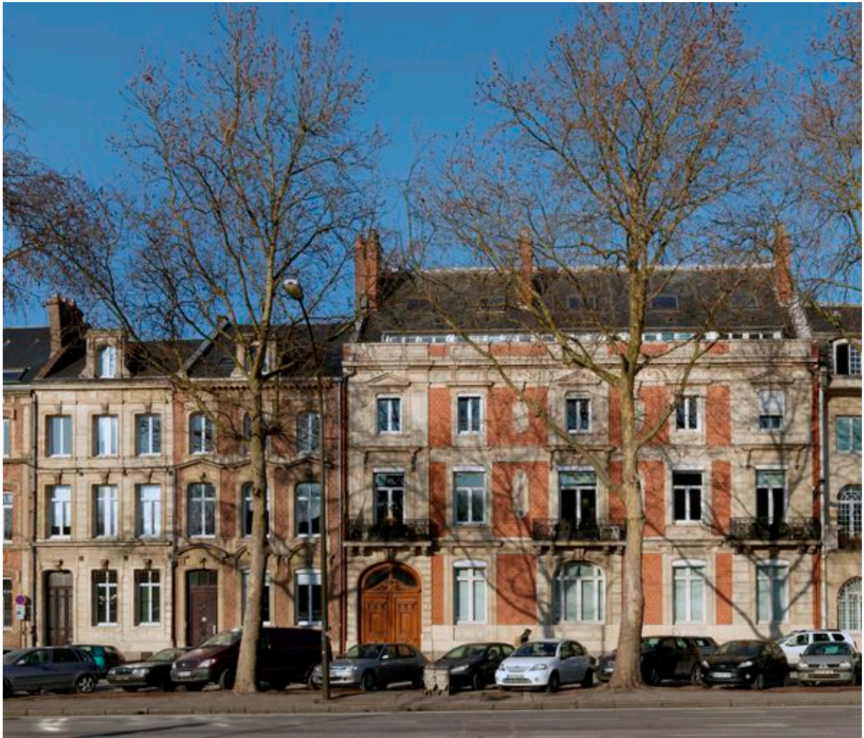
Vue de situation, maisons à gauche de l'image.
