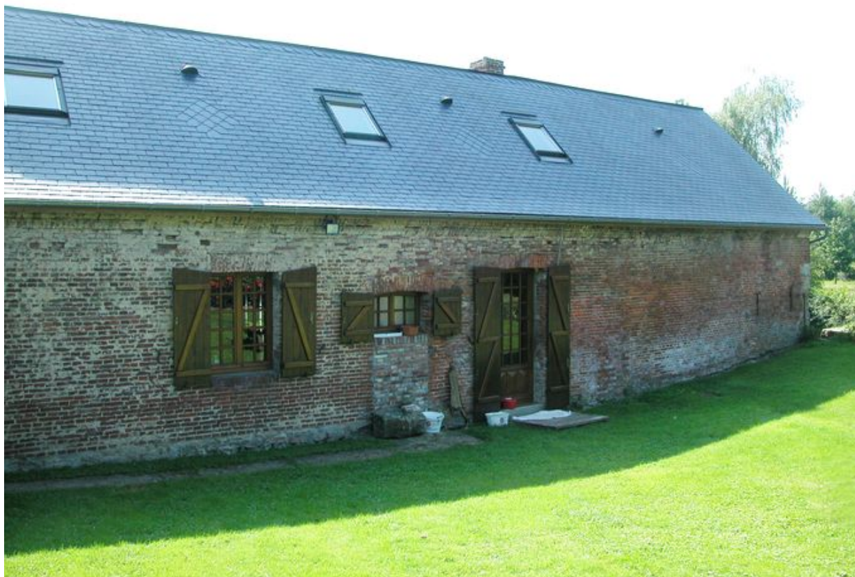
Façade sur jardin de l'ancien moulin hydraulique et de la partie habitation attenante.
