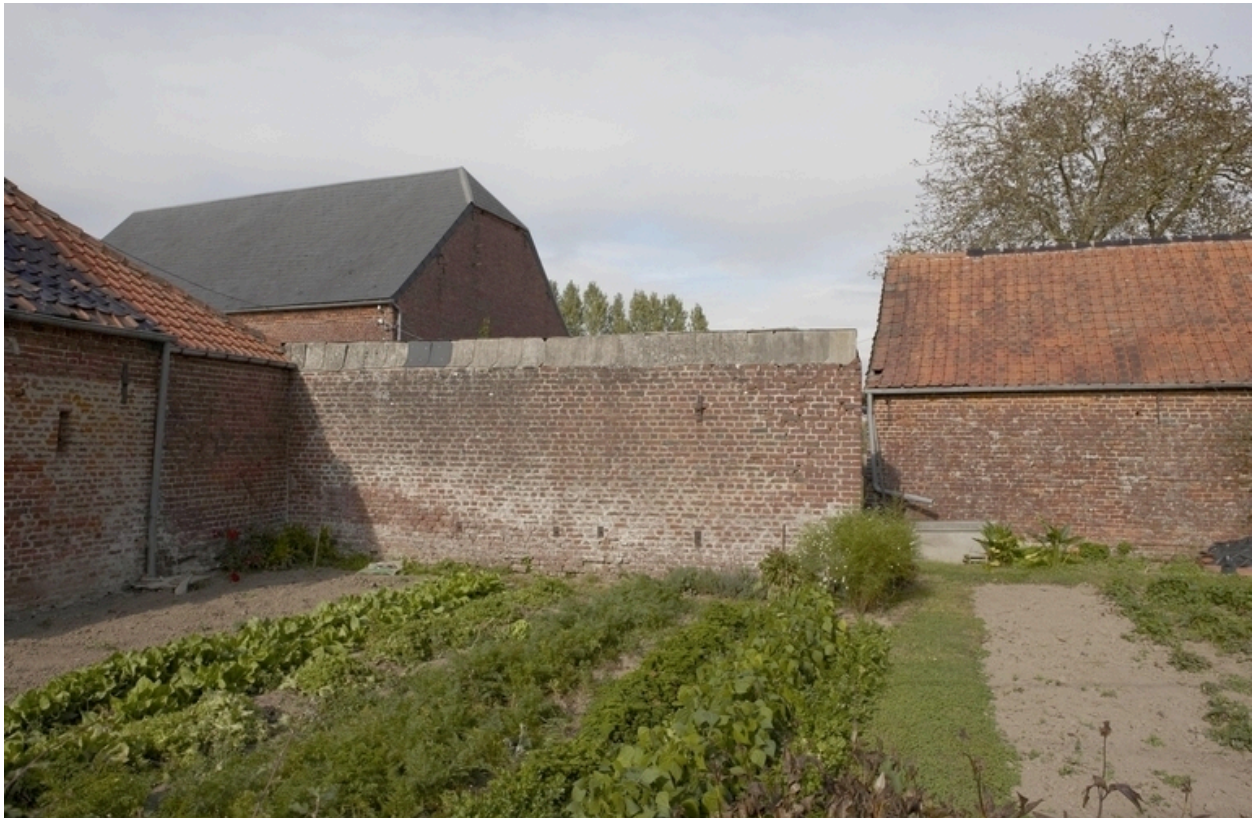
Vue du mur de clôture, d'une remise et du pignon de la grange.
