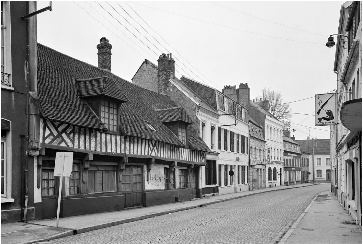
L'Âne rayé et Le Petit-Écu. Vue générale (1981).
