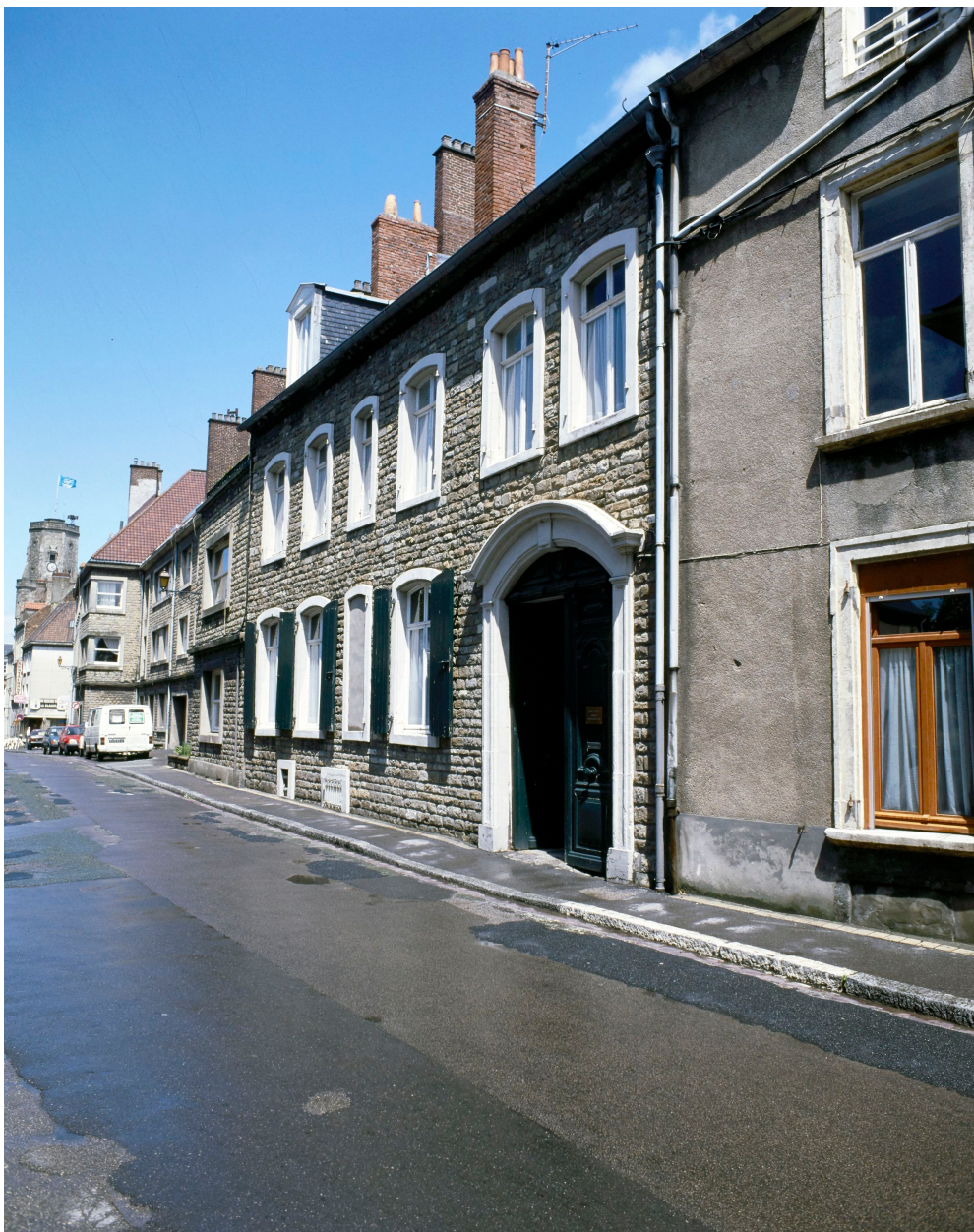
Façade sur voie.
