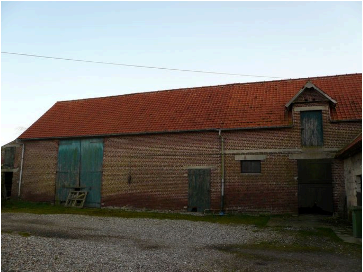
Vue de la grange.
