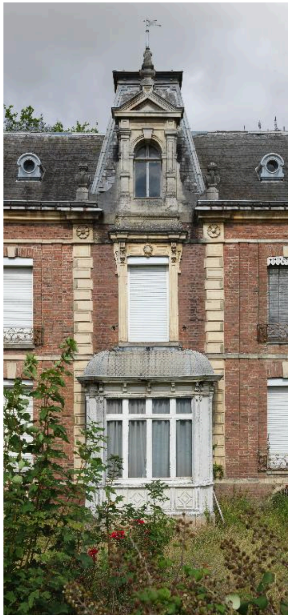
Travée centrale de la façade antérieure.
