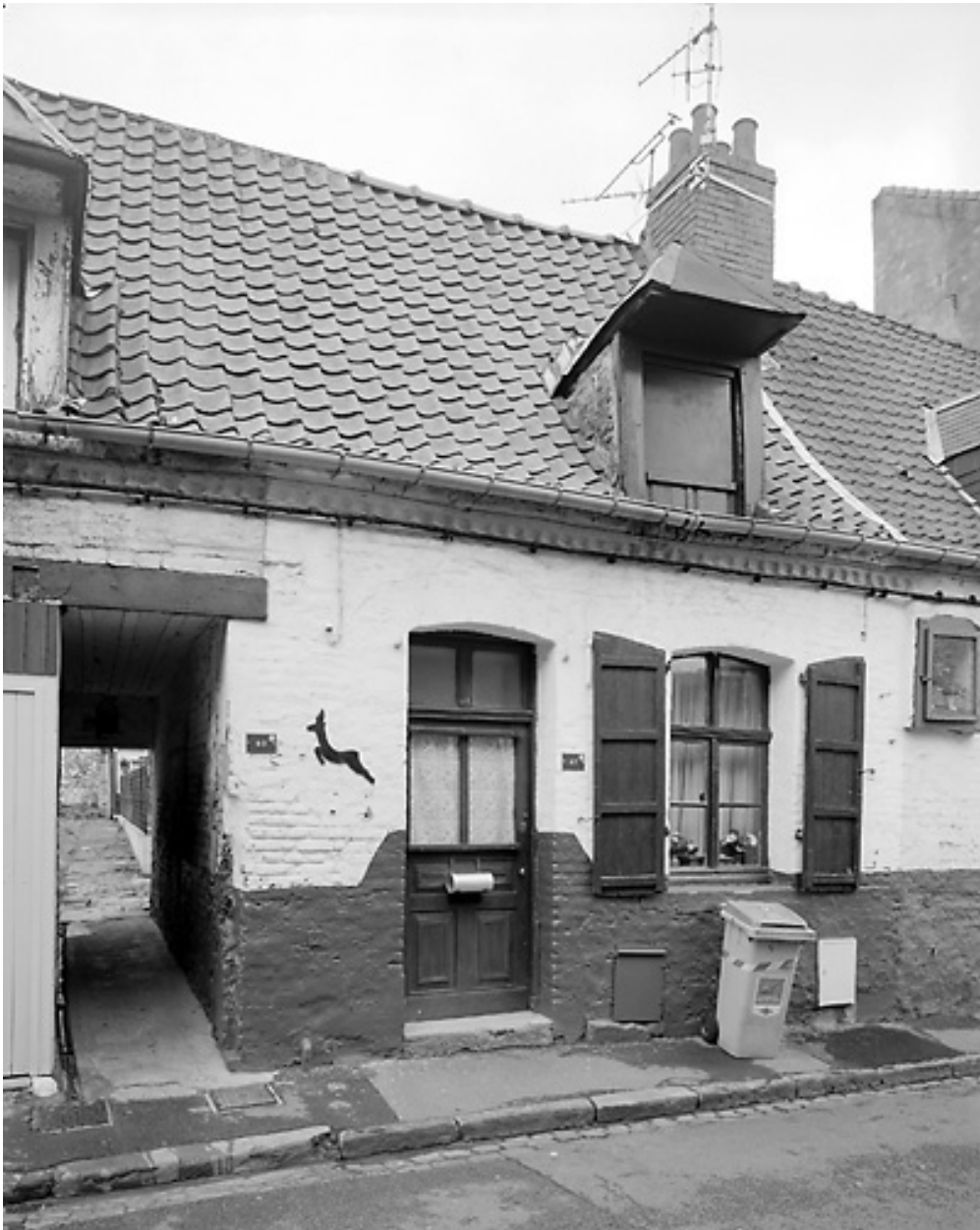
Vue générale du n° 65 de la rue Neuve (état en 2000).
