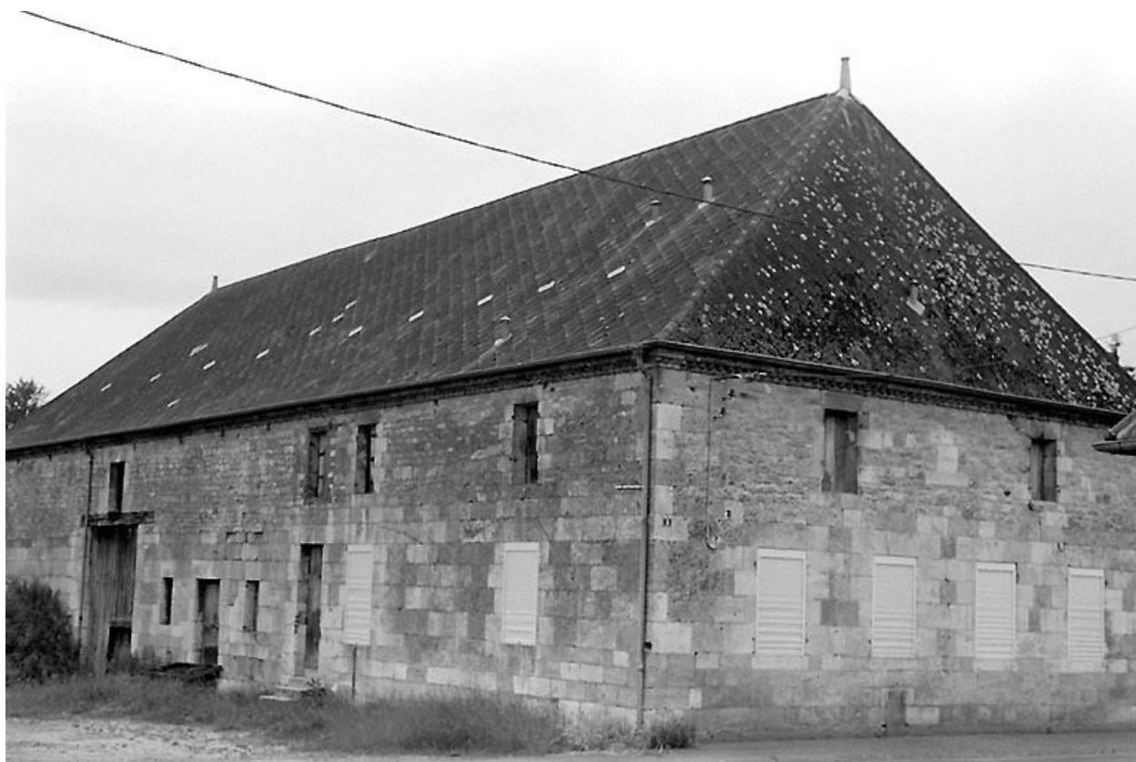
Vue depuis le nord-est.
