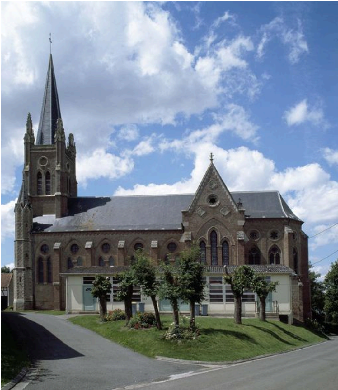
Vue générale depuis l'est.
