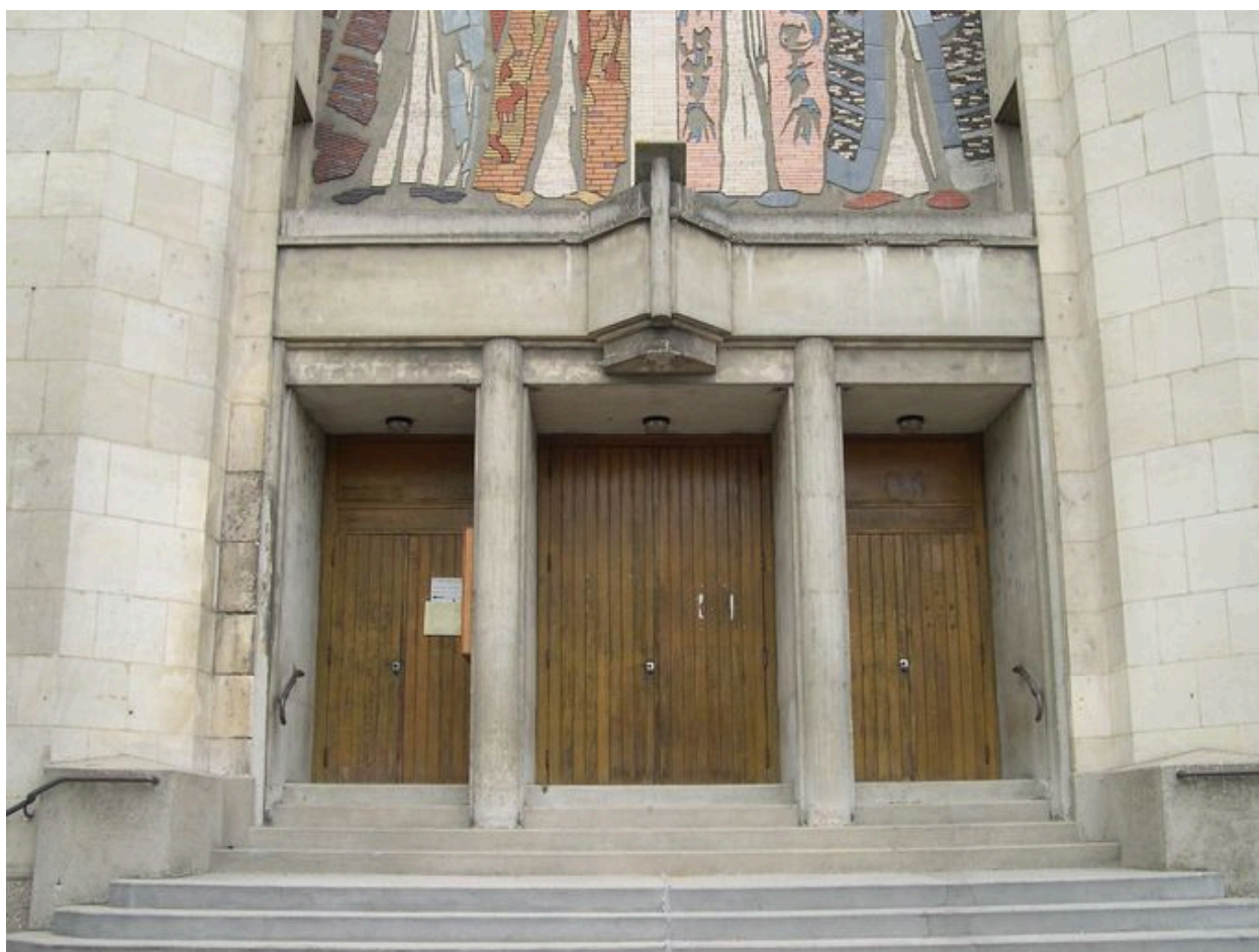
Vue de détail : portails de la façade ouest.
