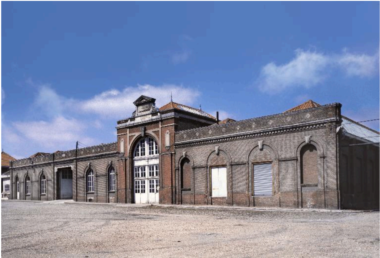
Vue de la façade sur cour du tissage de toile.
