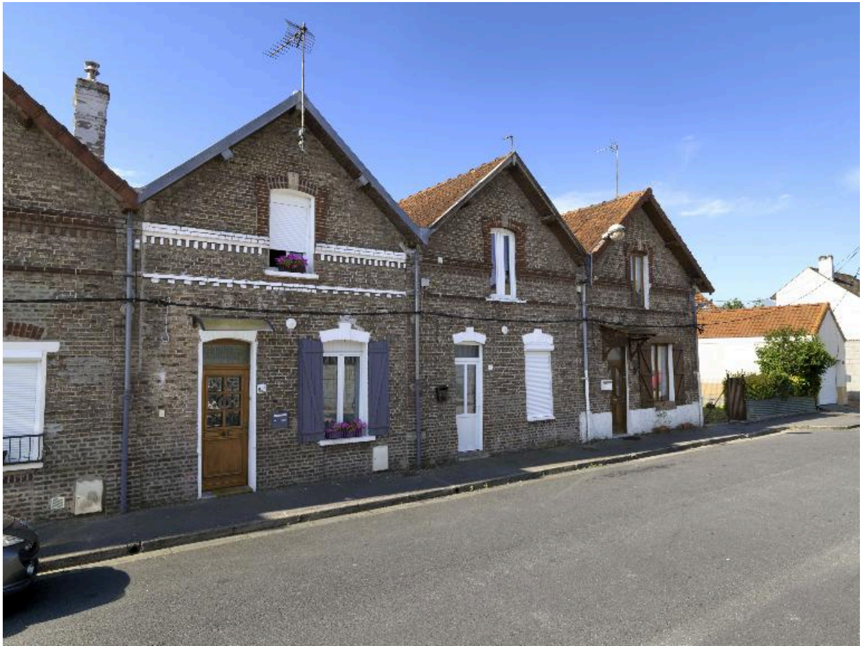
Logements ouvriers de la rue Nouvelle-Cité-Saint.
