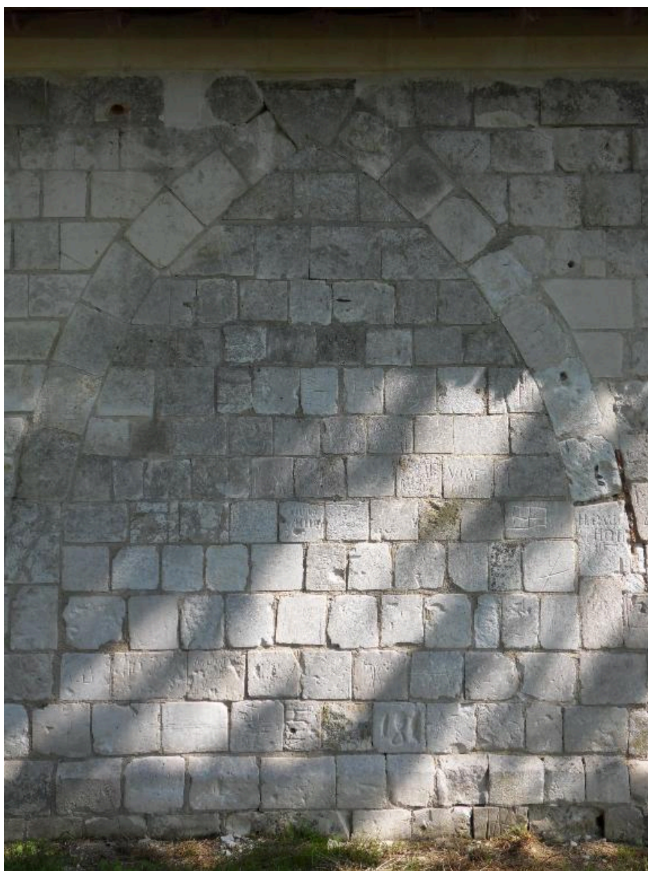
Deuxième arcature mur sud.
