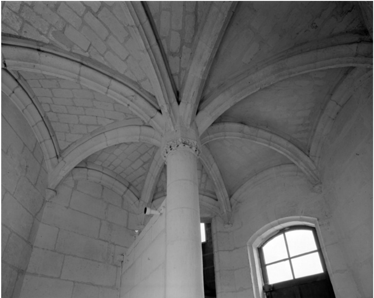
La voûte de la cage d'escalier.
