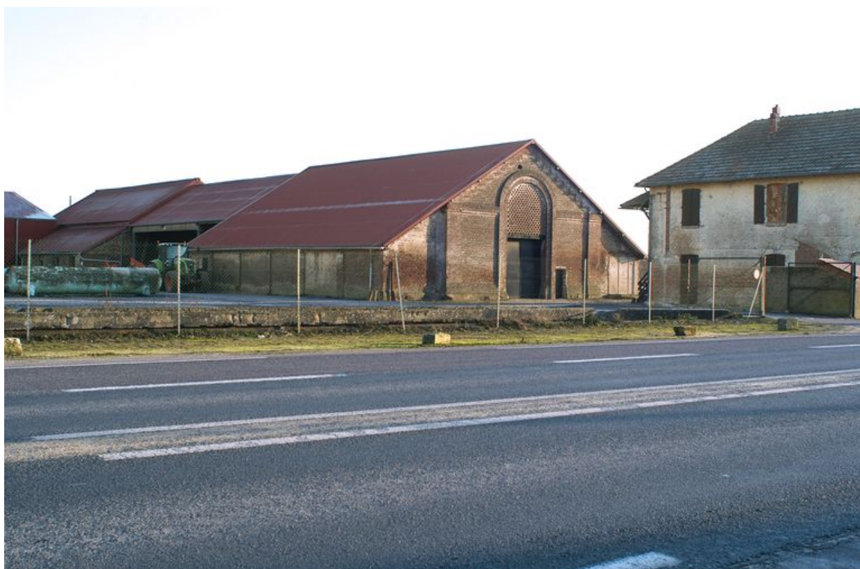
Entrepôt industriel sud, vue d'ensemble.
