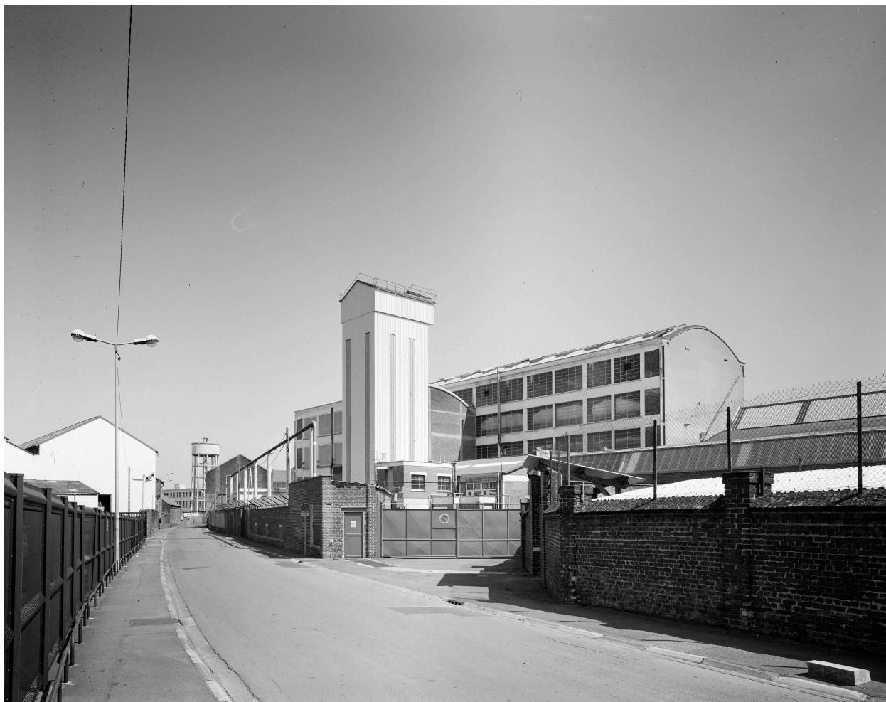
Vue générale depuis la rue de l'Industrie : au premier plan la halle 27, l'atelier G et la tour d'essai des mécanismes (90).
