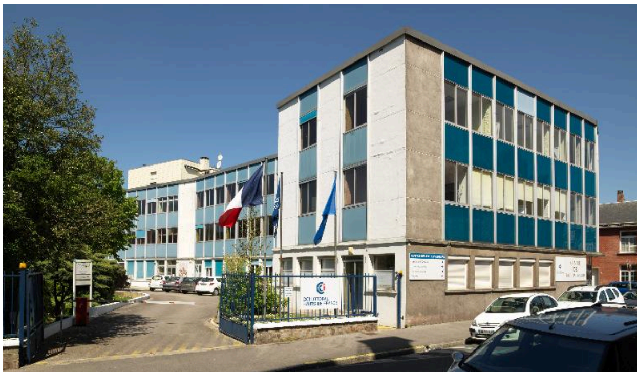
Immeuble de bureaux de la Chambre de commerce. Vue depuis la rue du Chevalier-de-la-Barre.
