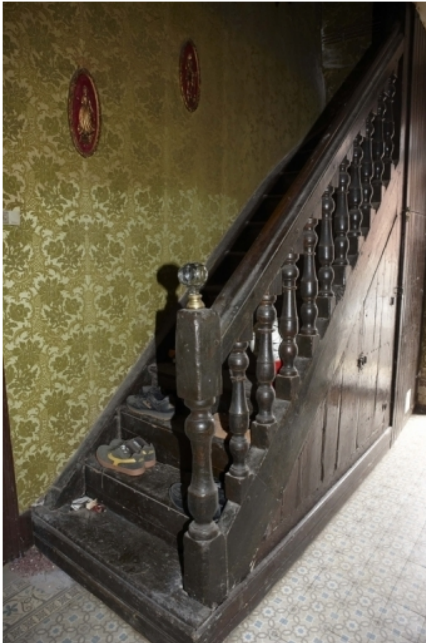
Détail du départ de l'escalier du logis.
