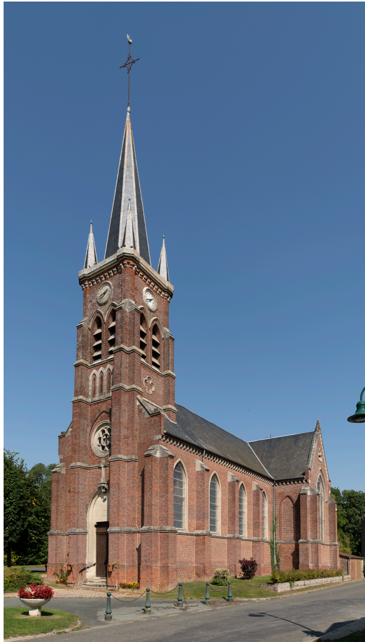
Église Saint-Denis, vue depuis le sud-ouest.
