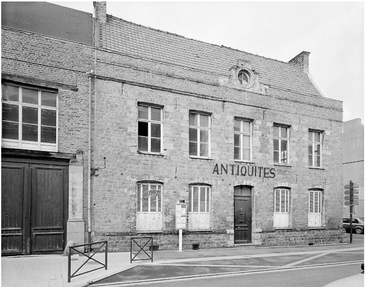
Façade rue Notre-Dame : vue générale (état en 2000).
