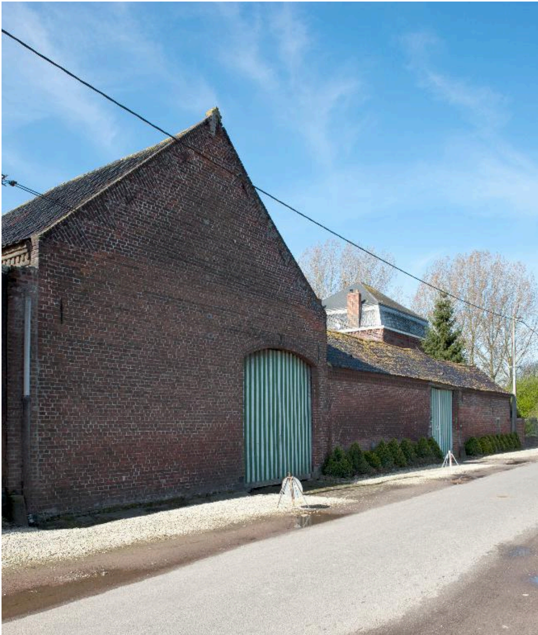
Vue générale d'une ferme à cour fermée 1522 rue du Bois.
