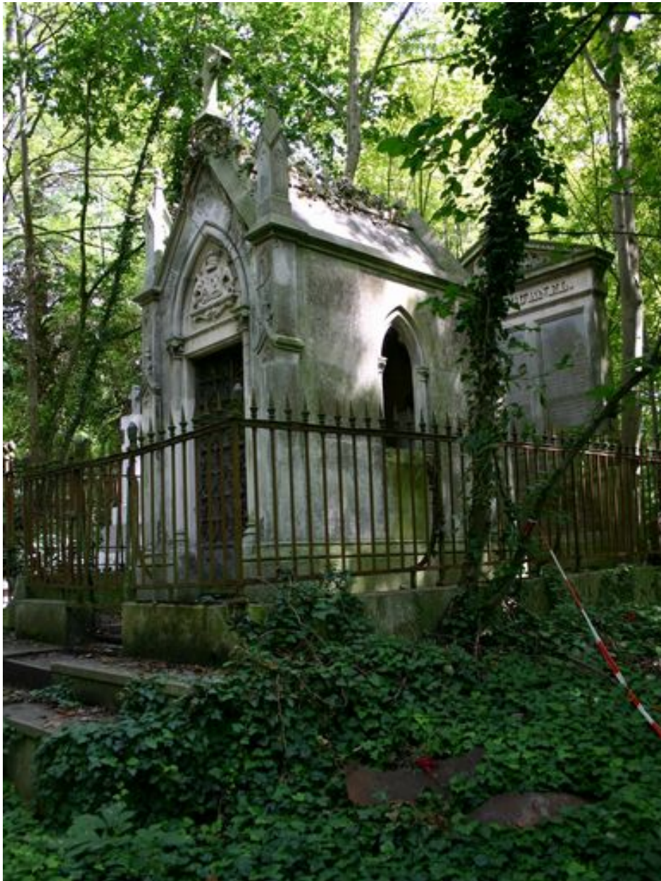
Vue générale, depuis le côté droit.
