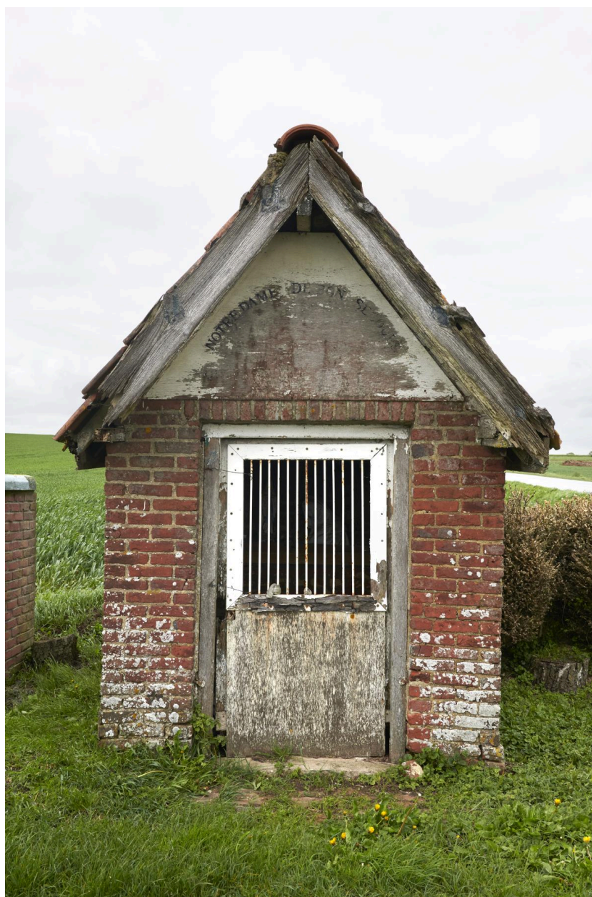
Vue de face de la chapelle.
