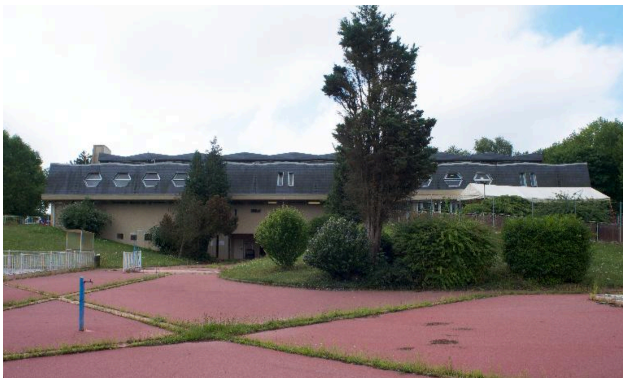
Façade nord, vue depuis les bassins extérieurs.
